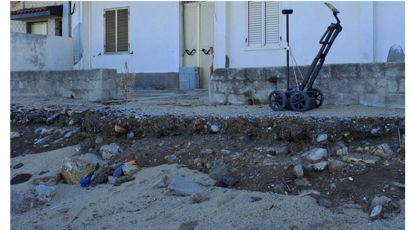
Figura 9 Depositi alluvionali misti a riporti antropici in corrispondenza dell'abitato di loc. Pennello
